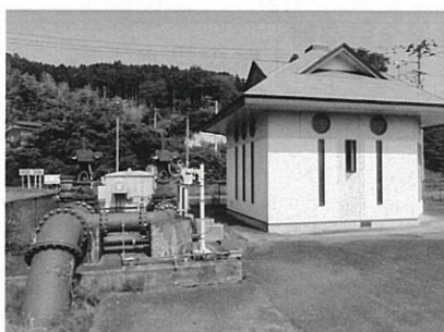
吉地揚水機場 (登米市石越町地内)
